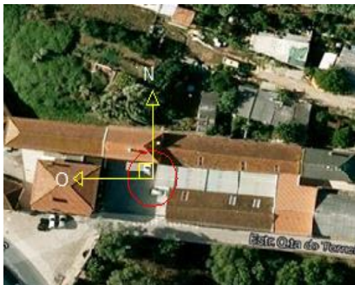
Figura 4.8 - Vista do exterior do edifício da fachada verde em Paço de Arcos, (Prazeres,2015)
