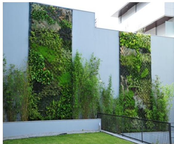
Figura 2.12 - Fachada verde em Condomínio Privado, Quinta das Nogueiras, Coimbra, Clorofila (2010)
