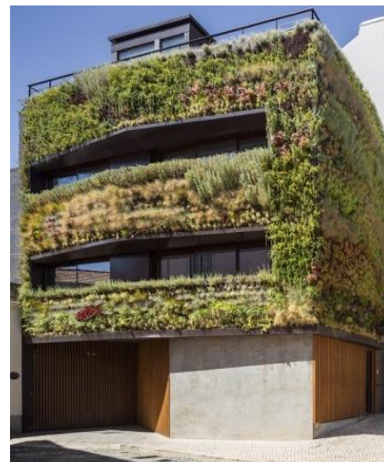
Figura 4.7 - Fachada verde da Travessa do Patrocínio, ID3D (2012)
