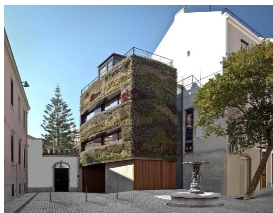
Figura 4.3 - Vista do exterior do edifício da fachada verde na Travessa do Patrocínio, ID3D (2012)
